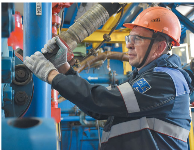
Слесарь по обслуживанию буровых 6-го разряда ООО «БНГРЭ» Виктор Безматерных осуществляет профилактический ремонт на КП-124
